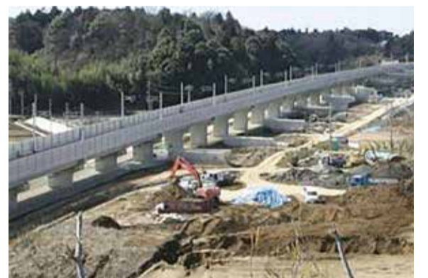
建設中の北千葉道路(千葉県ホームページより)
