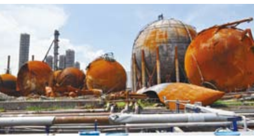
コスモ石油の事故現場
