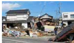
旭市の津波被害
